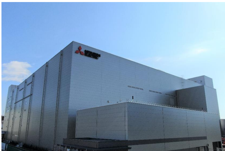
Nuovo impianto presso Kamakura Works
