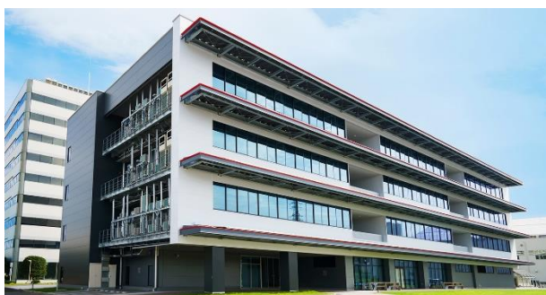
Struttura di collaudo ZEB SUSTIE
