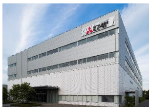
Edificio Industrial Mechatronics Systems Works (presso la sede di Nagoya Works)
