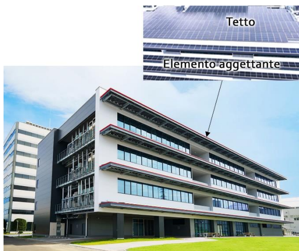
Struttura di collaudo ZEB SUSTIE
